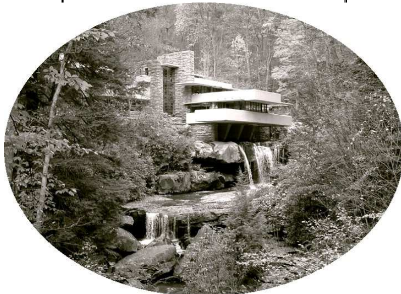
Frank Lloyd Wright, Residência Kaufmann (Fallingwater) em Bear Run, 1936
